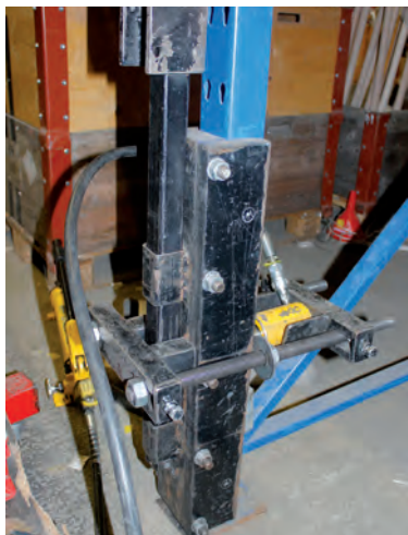
Hydraulik im Einsatz. Reparatur unter voller Last.
