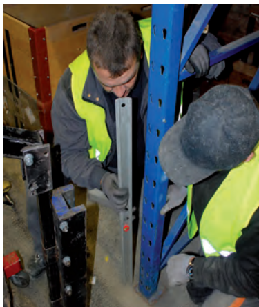
Prüfung des Reparaturfortschrittes.
