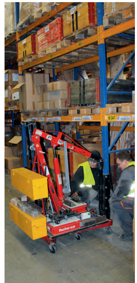
Reparatur unter voller Last.
