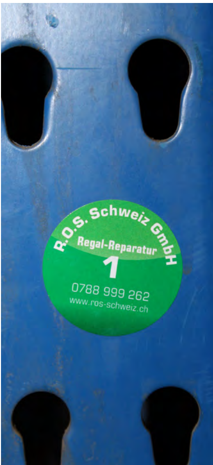
Reparierte Stütze mit Garantieetickete.
