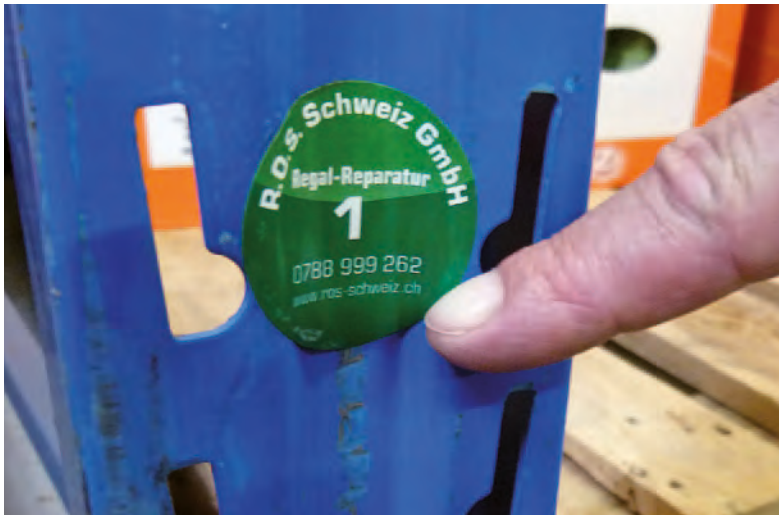
Eine «1» nach der ersten, eine «2» nach der zweiten Reparatur.
